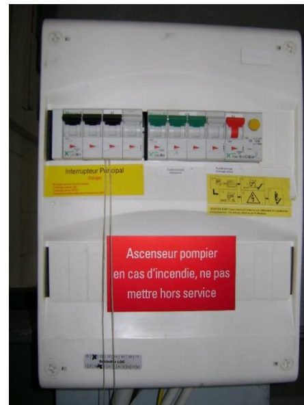
Plaquette gravée pour les interrupteurs et fusibles des alimentations ainsi que les alimentations de secours.
