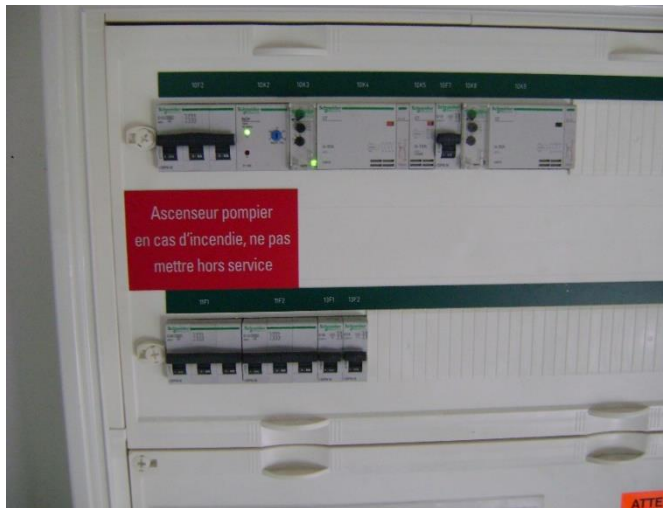
Plaquette gravée pour les interrupteurs et fusibles des alimentations ainsi que les alimentations de secours.
