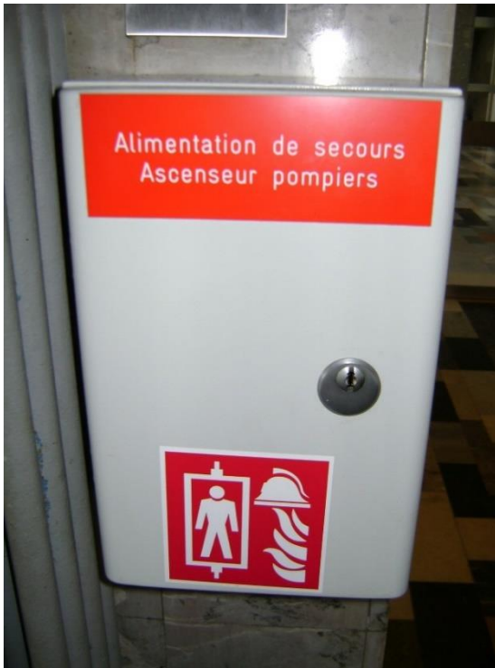
Indications sur le commutateur en courant de secours (installations existantes)
