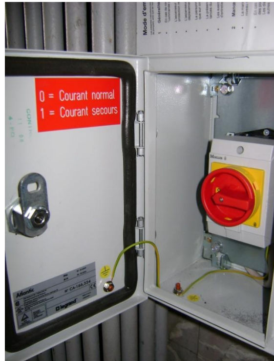
Indications sur le commutateur en courant de secours (installations existantes)
